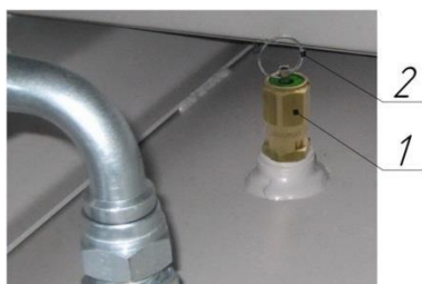
Рисунок 9 – Клапан предохранительный пружинного типа
