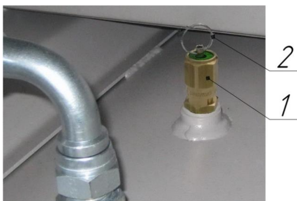
Рисунок 10 – Клапан предохранительный пружинного типа
