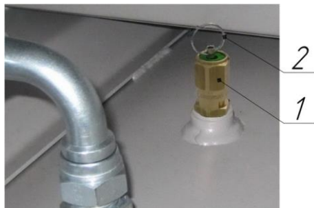
Рисунок 9 – Клапан предохранительный пружинного типа
